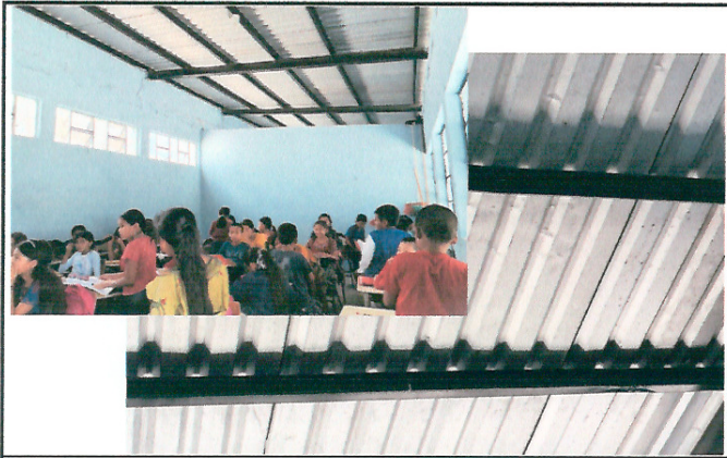
Foto 1: MEJORAMIENTO DE CUBIERTA DE LÁMINA DE AULA
