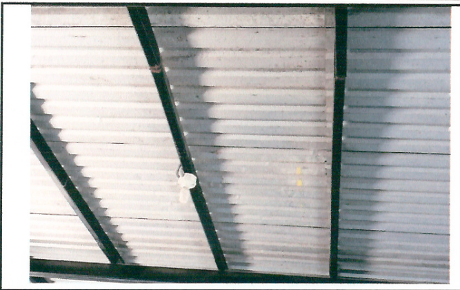
Foto 2: MEJORAMIENTO DE CUBIERTA DE LÁMINA DE AULA
