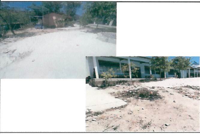
Foto 4: MEJORAMIENTO DE LOSA DE PATIO
